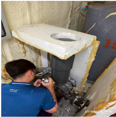
ภาพที่ 2.9 งานบำรุงรักษาระบบเติมอากาศระบบบำบัดน้ำเสีย
