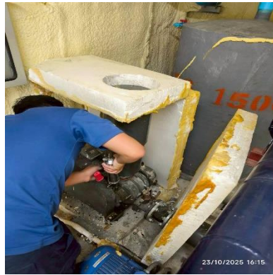
ภาพที่ 2.9 งานบำรุงรักษาระบบเติมอากาศระบบบำบัดน้ำเสีย
